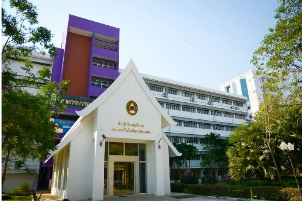
ภาพที่ 1 อาคารบรรณราชนครินทร์
